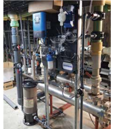
Sobre estas líneas, obras de instalación de nuevos paneles fotovoltaicos. A la derecha, instalación de la nueva digitalización y automatización de conducciones en la red de agua termal del Balneario.
